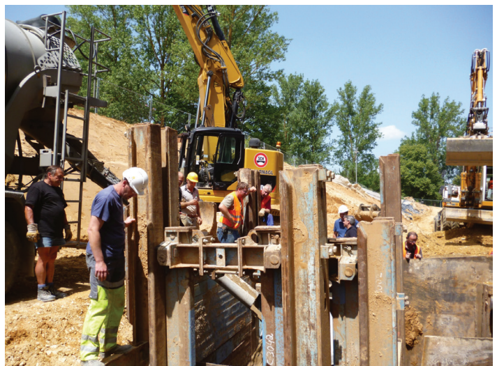
Baustelle in Weinfeld. Foto: Ingenieurbüro LOGIC
