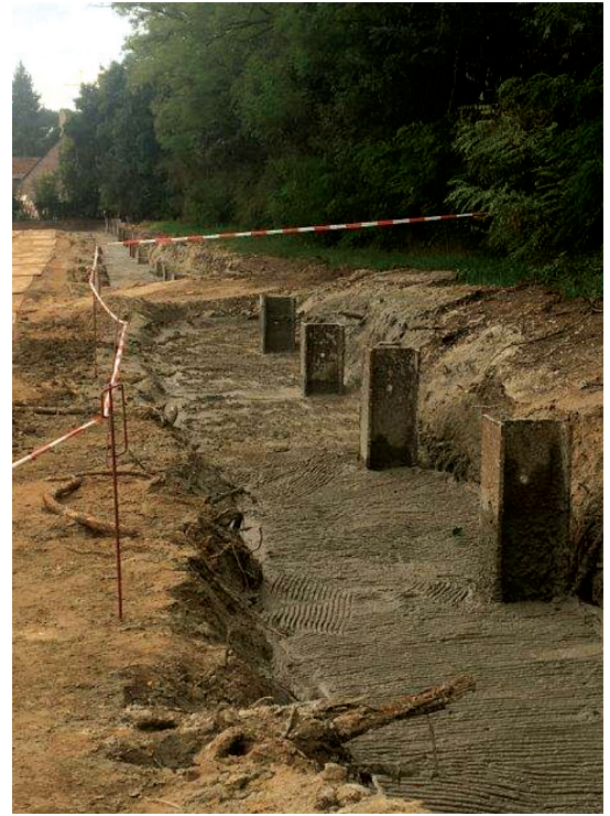
Frisch verfüllte Träger-Flüssigbodenwand. Foto: Ingenieurbüro LOGIC
