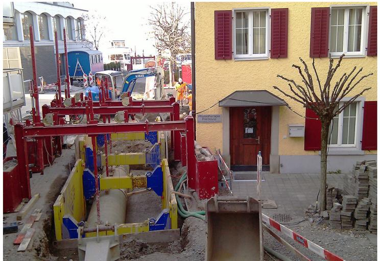
Gegenüber den bindigen Böden hat der, entsprechend RAL GZ 507 hergestellte Flüssigboden den großen Vorteil, dass er bereits nach wenigen Stunden bei geeigneten Rezepturen eine relativ hohe Tragfähigkeit erreichen kann, so dass für so eingestellten Flüssigboden generell der Straßenaufbau sehr schnell wieder aufgebracht werden darf. Da der Flüssigboden bei entsprechender Gütesicherung nach RAL Gütezeichen 507 unter
