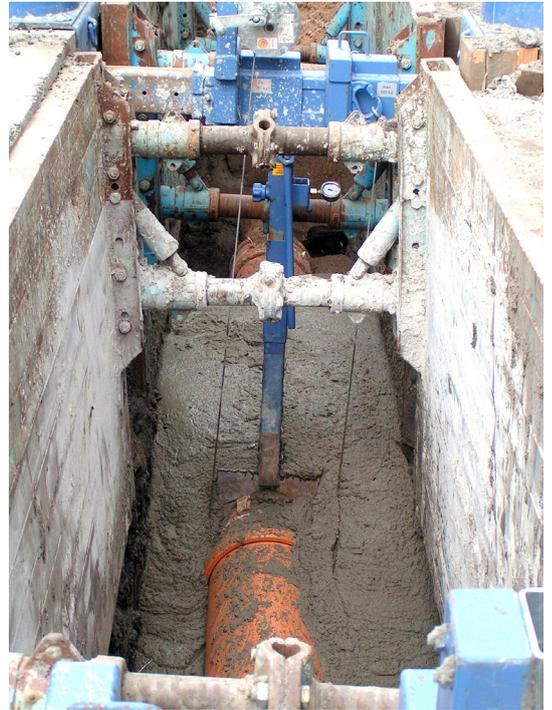
*Einbau in Flüssigboden, der das Rohr nahtlos umschließt. Nach der eigenständigen Verfestigung gibt es kein Nachsacken des Bodens - spätere Straßeneinbrüche sind ausgeschlossen. Foto: Ing. Büro LOGIC*
