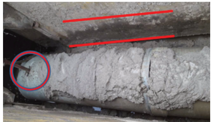
Hydraulischer Grundbruch in einem nicht bindigen Boden nach einem Starkregenereignis; Foto: Ing. Büro LOGIC
