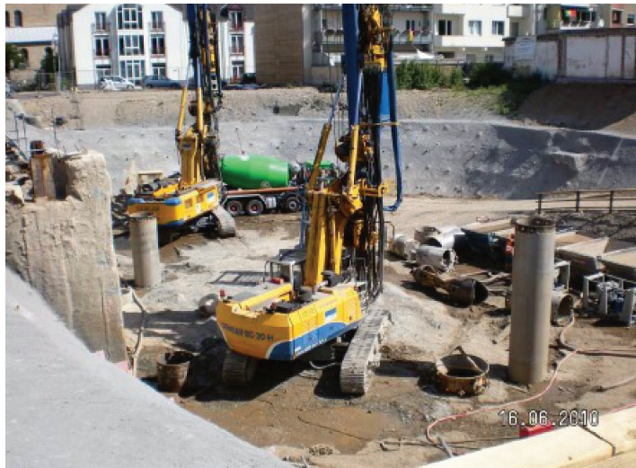
Sanierung der Einsturzstelle mit überschneidenden Bohrpfählen aus RSS Flüssigboden, Foto: Ing. Büro LOGIC
