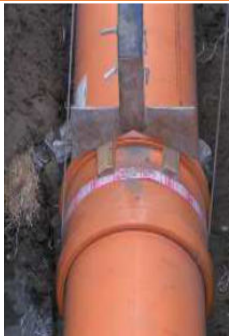
Abbildung 20: Drainage "Holländische Bauweise"
