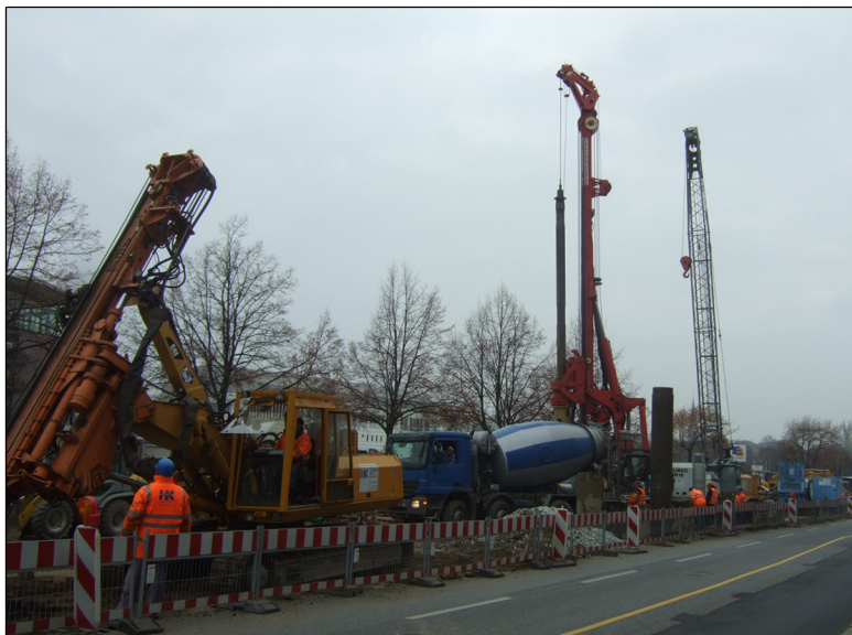
Bohrlochverfüllung mit RSS Flüssigboden®
