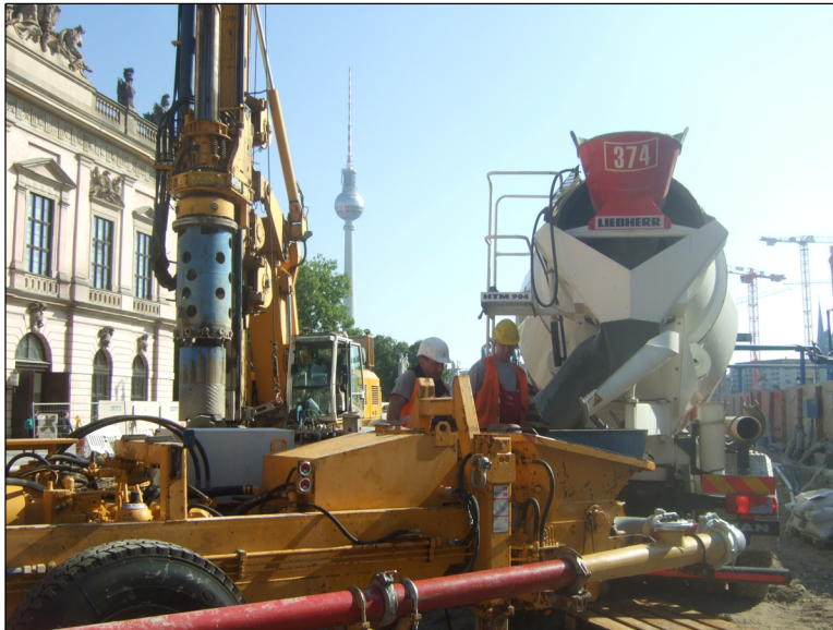
Bohrlöcherverfüllung mit RSS Flüssigboden®
