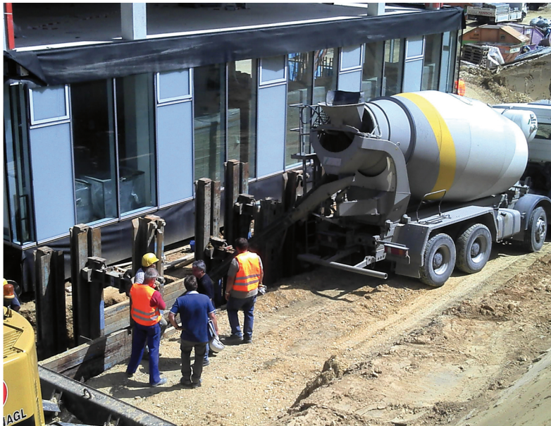
Verfüllung mit RSS Flüssigboden®
