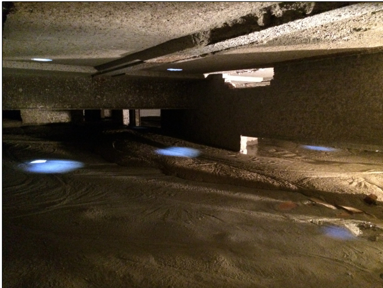
U-Bahn-Tunnel Dresdner Straße Verfüllung mit Flüssigboden
