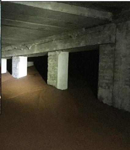
Verfüllung mit RSS Flüssigboden
