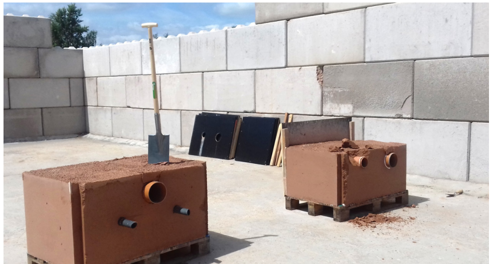
Beim Info-Tag wurden Probekörper mit RSS Flüssigboden nach RAL Gütezeichen 507 verfüllt.
