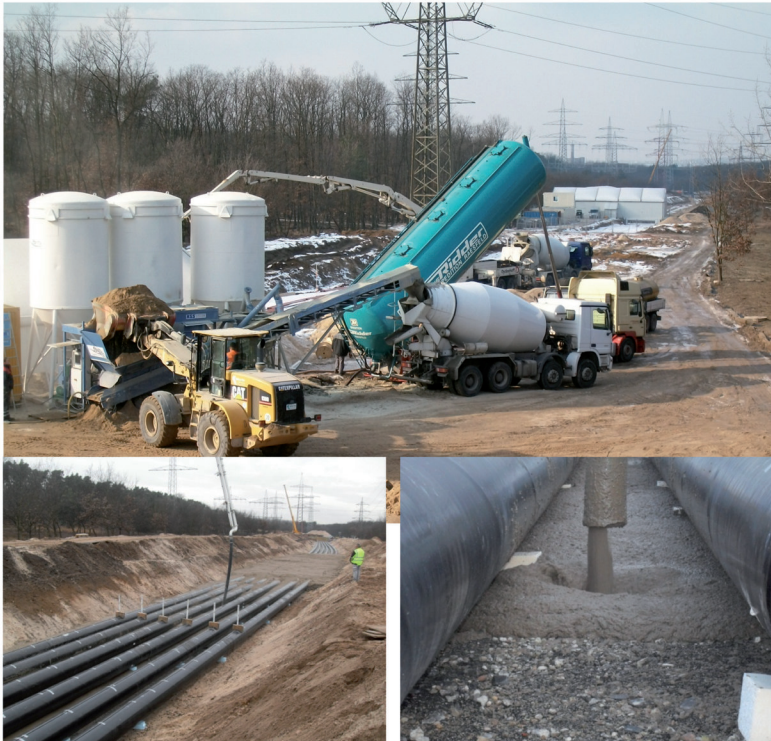
Graben verfüllt mit RSS Flüssigboden®
