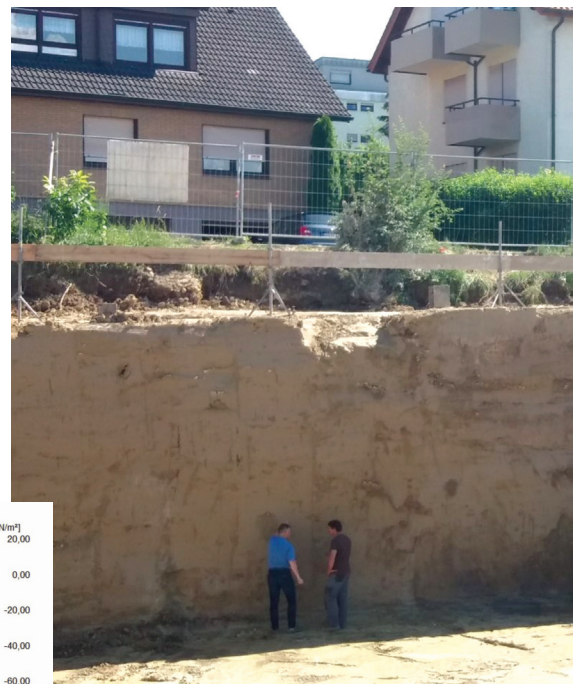
RSS Wand auf der Baustelle in Bad Rappenau - in der Phase des Endaushubs der Grube, d.h. der höchsten Belastung der RSS Wand - und das dazugehörige FEM-Modell zur Berechnung der Lastenverteilung. Foto + Grafik: Ingenieurbüro LOGIC
