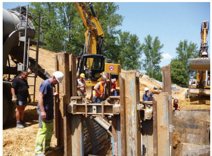
Baustelle in Weinfeld. Foto: Ingenieurbüro LOGIC
