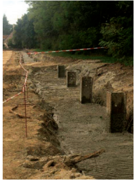
Frisch verfüllte Träger-Flüssigbodenwand. Foto: Ingenieurbüro LOGIC
