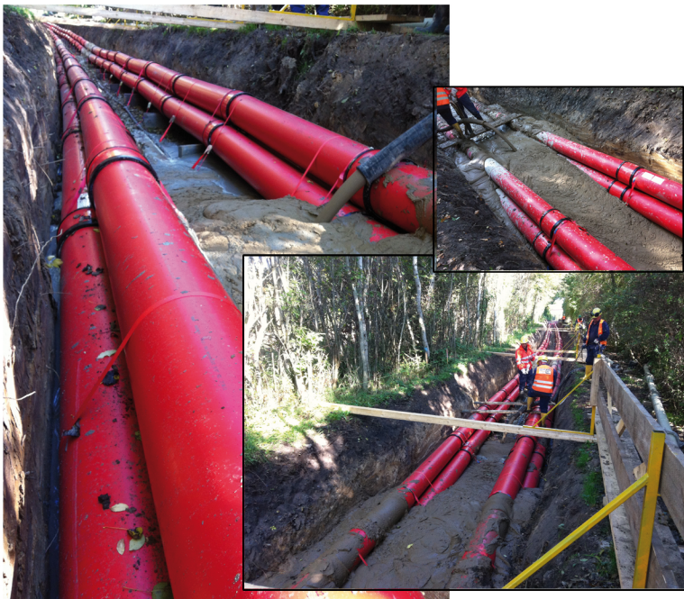
Graben verfüllt mit RSS Flüssigboden®
