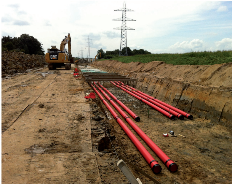
Graben verfüllt mit RSS Flüssigboden®
