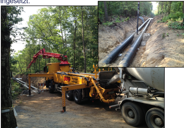
Verfüllung mit RSS Flüssigboden®
