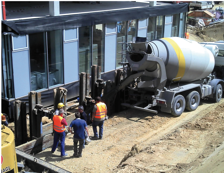
Backfilling with RSS® Flüssigboden
