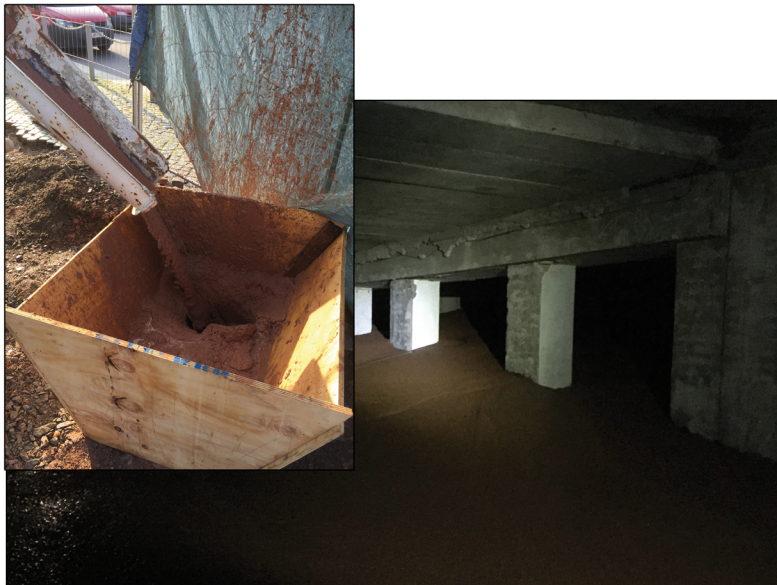
Backfilling with RSS® Flüssigboden
