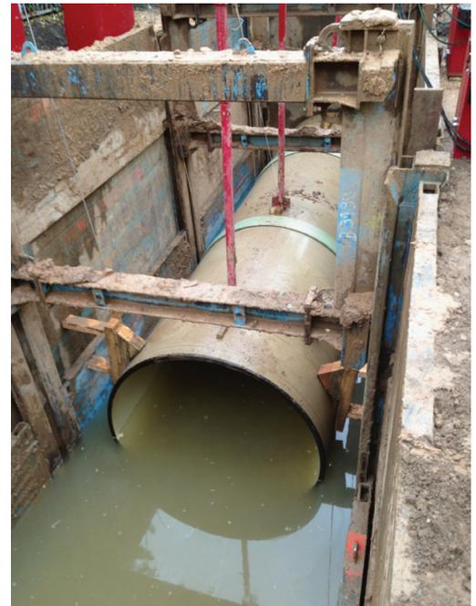
*Einbau eines Abwasserrohres bei erhöhtem Grundwasser mittels RSS- Rohrverlegehilfe in Flüssigboden. Foto: FiFB Leipzig*
