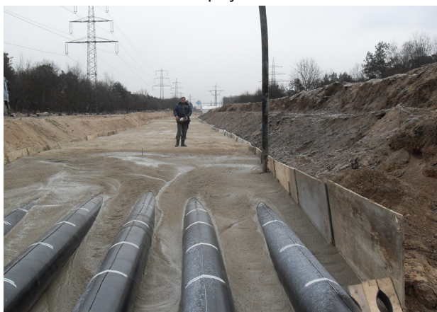
Zukunftsweisend: Erdkabelverlegung in Flüssigboden. Foto: PROV
