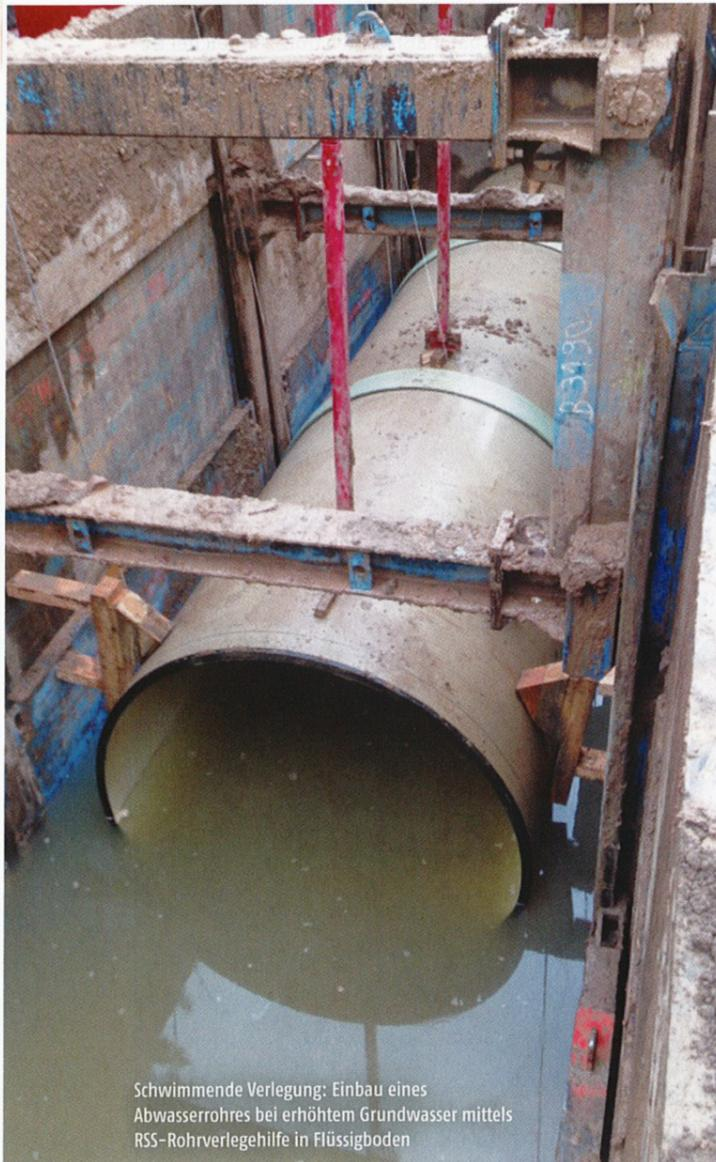
Schwimmende Verlegung: Einbau eines Abwasserrohres bei erhöhtem Grundwasser mittels RSS-Rohrverlegehilfe in Flüssigboden
