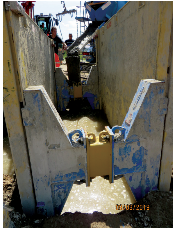
Mittels Rohrverlegehilfen werden die Rohre im Grundwasser des Grabens fixiert und dann in RSS-Flüssigboden eingebettet. Dank der „Schwimmenden Verlegung“ ist Bauen im Grundwasser überhaupt erst möglich geworden. Foto: Zink-Ingenieure (Offenburg)
