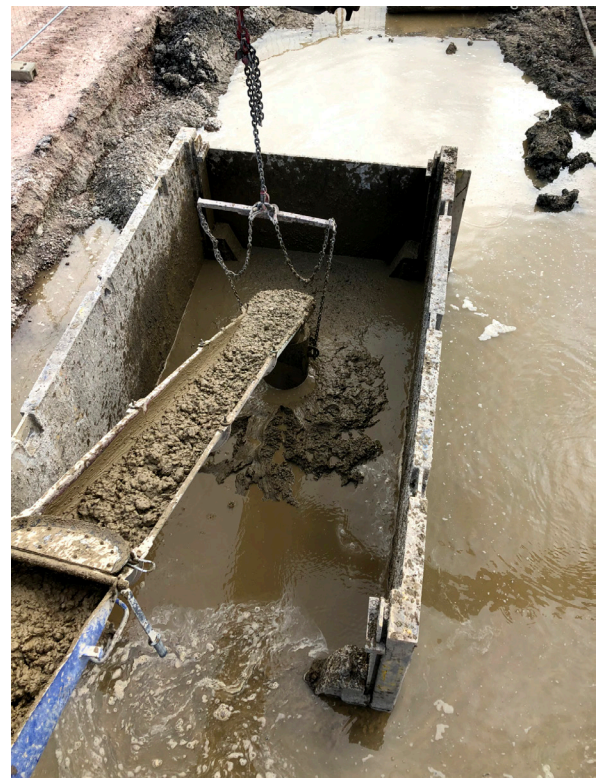
Beim Einbau des RSS-Flüssigboden wird das Grundwasser verdrängt. So ist „Bauen unter Wasser“ erst möglich. Foto: Lorenz Burgert GmbH
