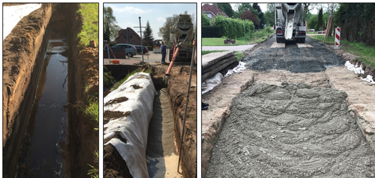
Technologie der gefaßten Bodenplatte mit RSS Flüssigboden®
