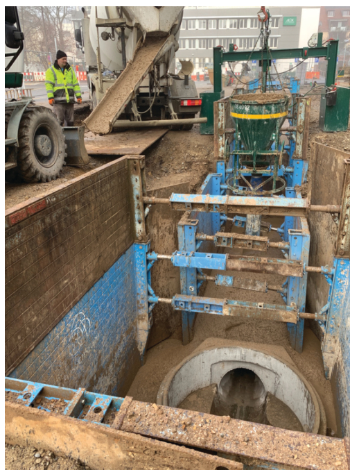
Einbau des RSS-Flüssigbodens auf der Baustelle am Europaplatz in Tübingen. Foto: Olaf Stolzenburg
