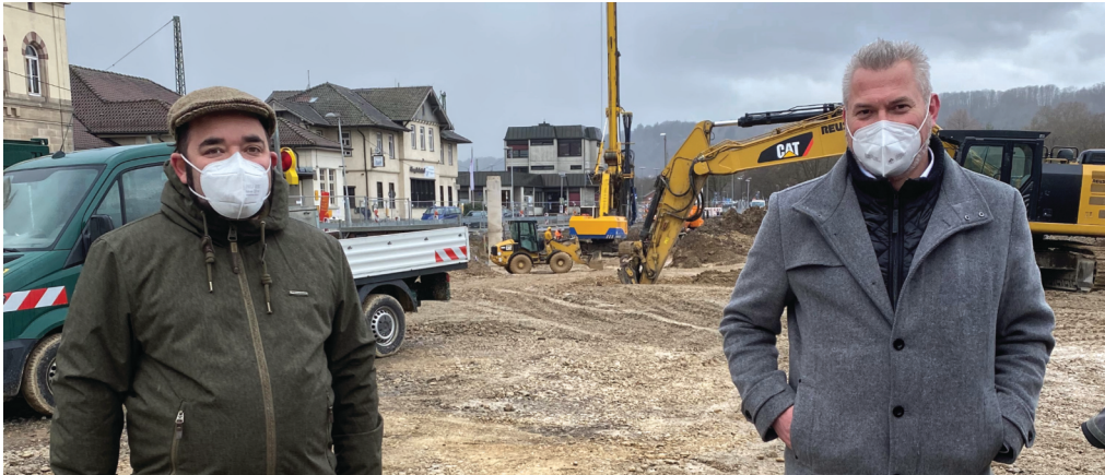
Treffen vor Ort auf der Baustelle in Tübingen: MdB Chris Kühn (l.) und Bernd Schwär von der Breinlinger Ingenieure Tiefbau GmbH. Foto: Markus Piechotta
