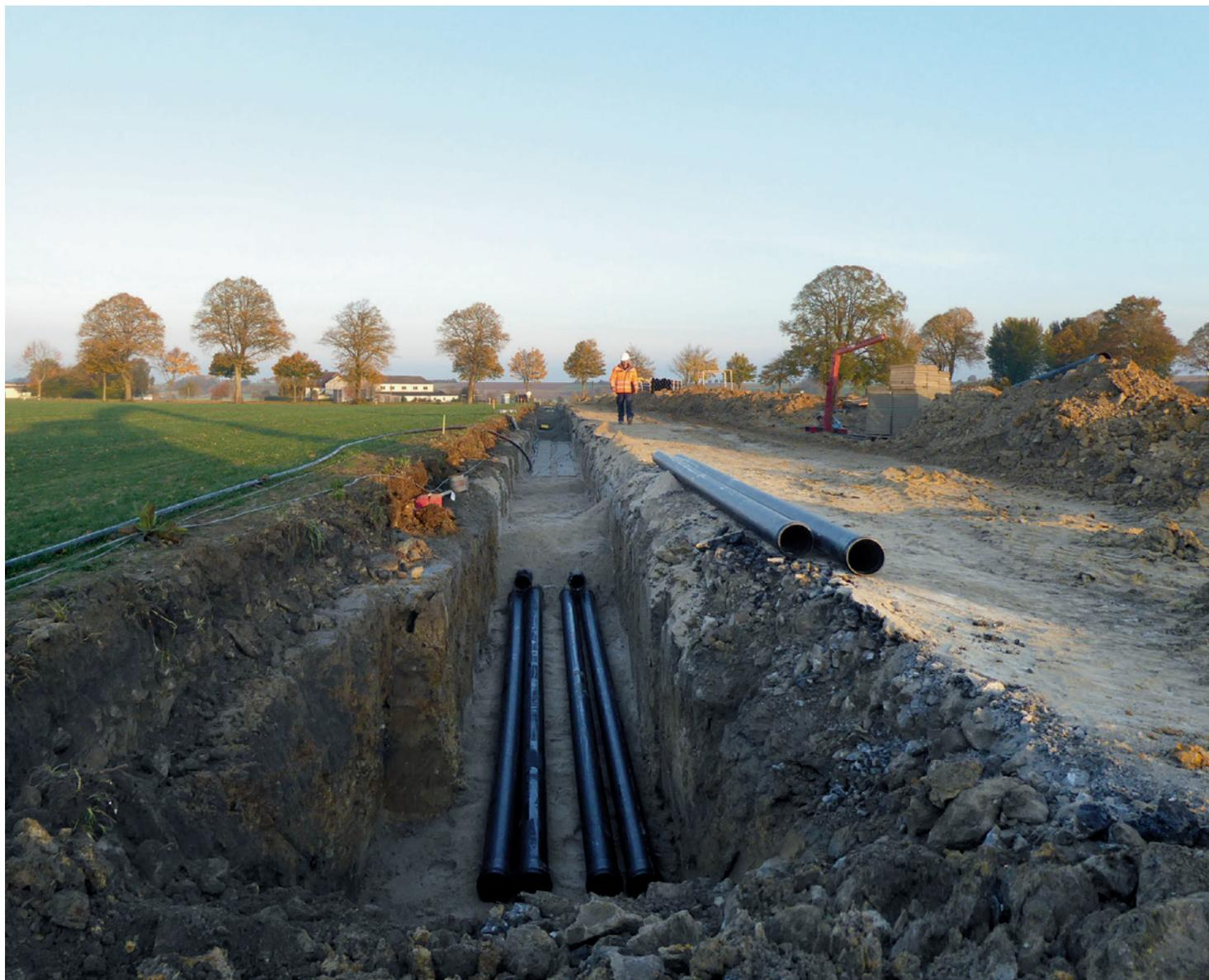
Im ersten Bauabschnitt werden nach derzeitigem Planungsstand Leerrohre in einer Tiefe von 1,40 m bis 1,80 m über den gesamten Verlauf der Trasse verlegt.
